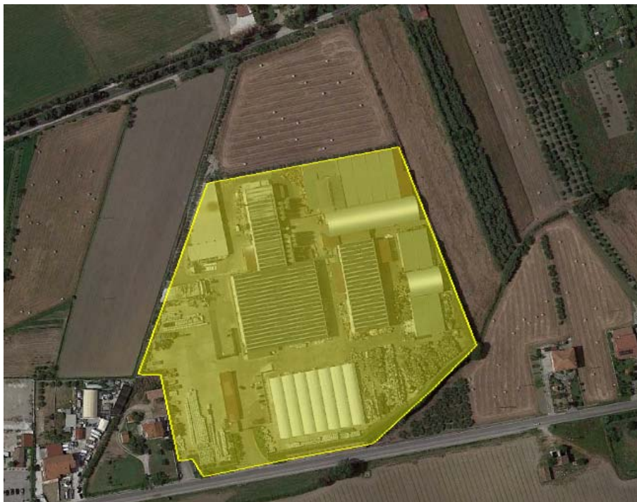
Figura 4: - Foto satellitare impianto, con indicazione del perimetro attualmente utilizzato (Fonte: Google)
