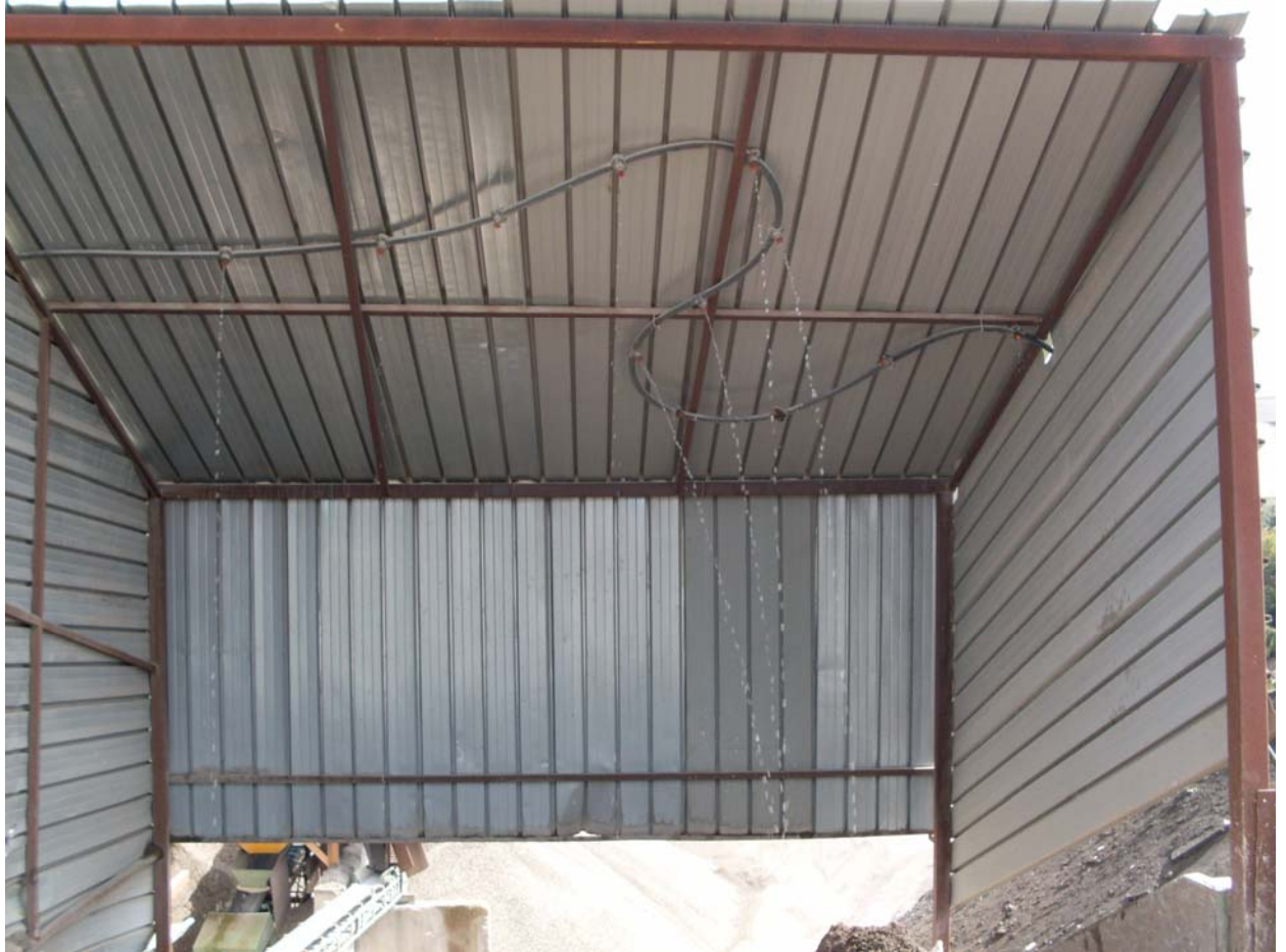
Figura 15 – Particolare degli ugelli presenti nella tramoggia di carico dell'impianto di triturazione
