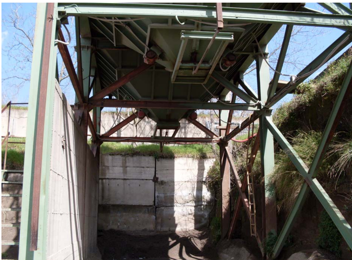
Figura 11 – Particolare delle condotte forzate sottostanti i silos di stoccaggio della sabbia
