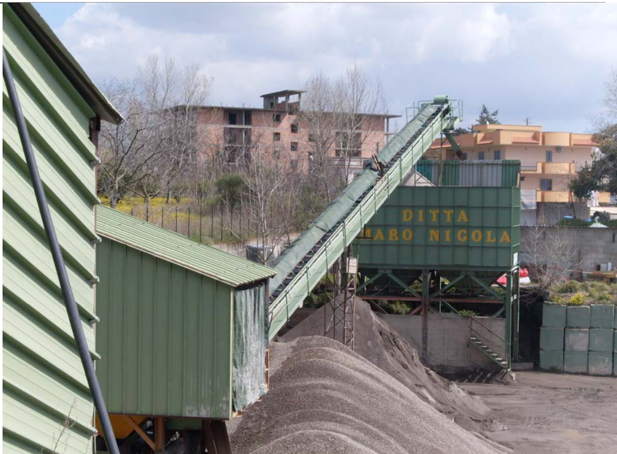
Figura 10 – Panoramica del nastro trasportatore della sabbia e dei due silos di stoccaggio
