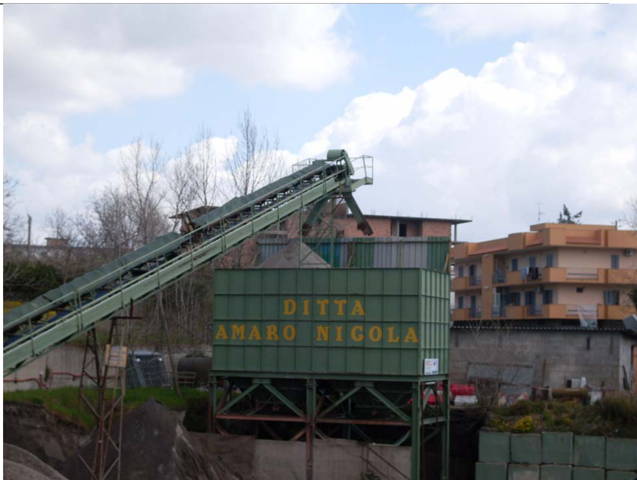
Figura 18 – Particolare della copertura dei nastri trasportatori
