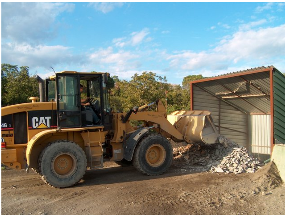
Figura 5 – Fase di carico dei rifiuti inerti nella tramoggia
