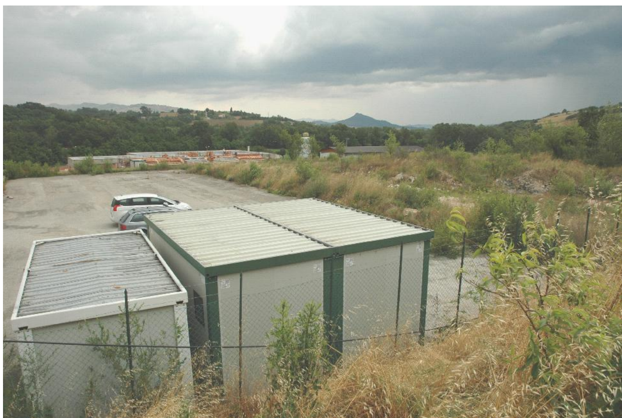
Fig.55 - Lotto 6 confinante ed adiacente al piazzale con Biocelle
