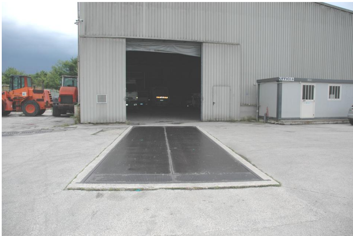
Fig.49 - Pesa e Capannone accettazione Rifiuti
