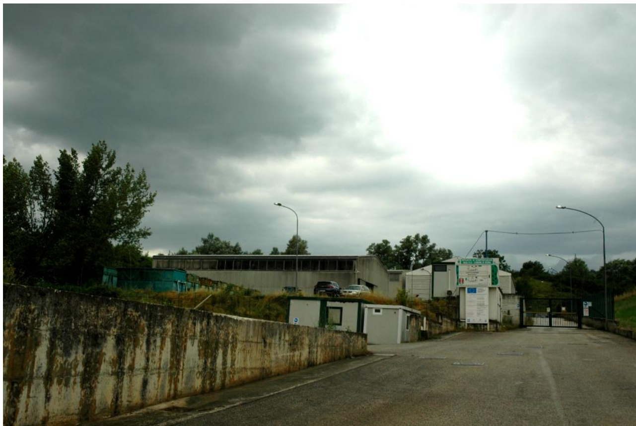
Fig. 44 - Ingresso all'Impianto di Compostaggio
