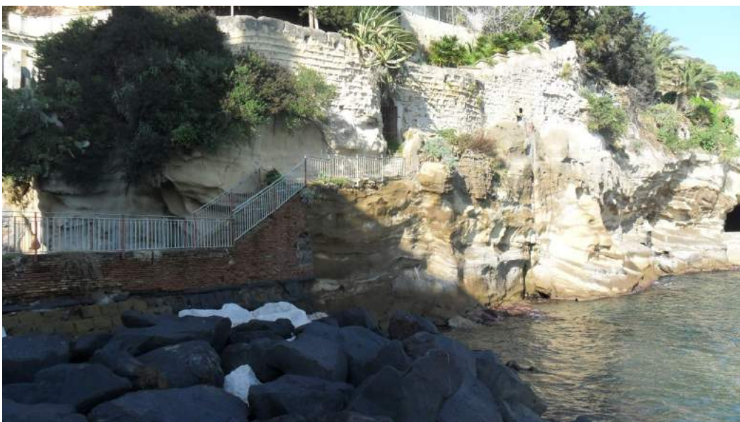
Figura 6– Scogliera emersa e muro verticale a difesa delle proprietà tra le quali è situato il costone
