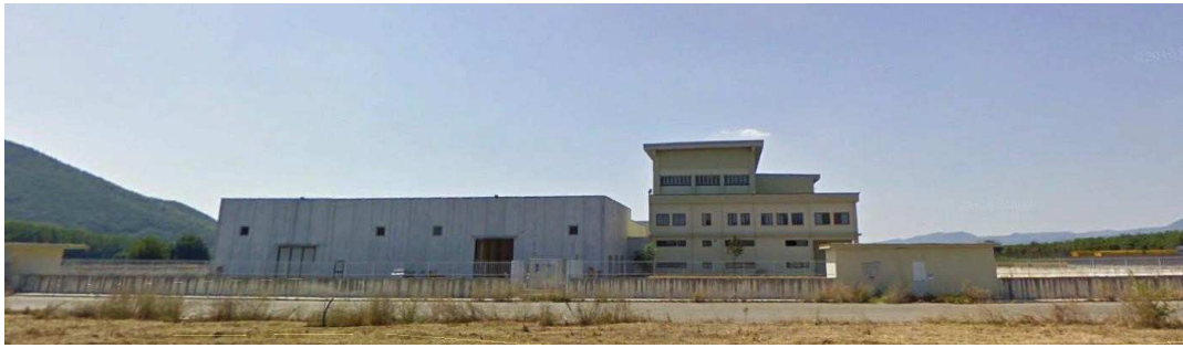
FIGURA 2 CARTIERA DI PIETRAMELARA ALLO STATO ATTUALE - VISTA GOOGLE EARTH LATO NORD-EST DA S.P.183
