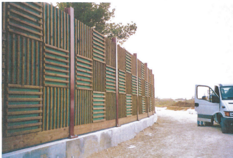
Foto 2 (esempio di recinzione con materiale fonoassorbente)
