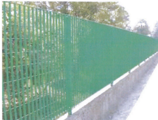
Foto 1 (esempio di recinzione "orsogrill")
