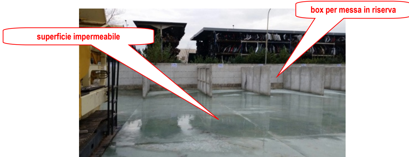
Foto 1: i box destinati alla messa in riserva dei rifiuti
