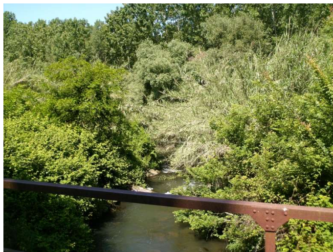
Figura 8. Sbocco del Canale nel fiume Tusciano
