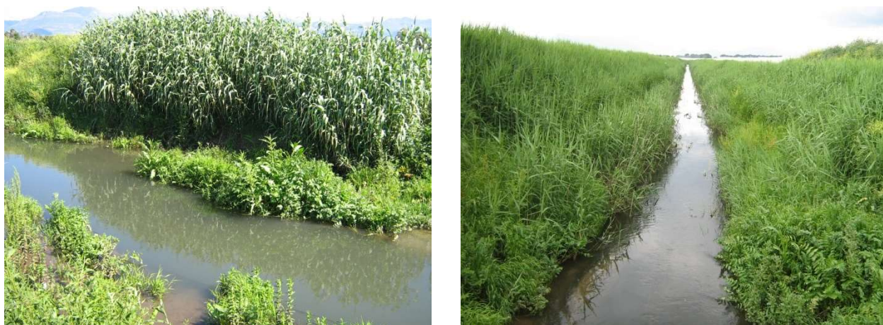
Figura 9. La sezione idraulica del canale, invasa dalla vegetazione
