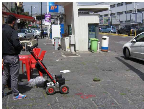
Figura 23 : Scansione presso sondaggio S5
