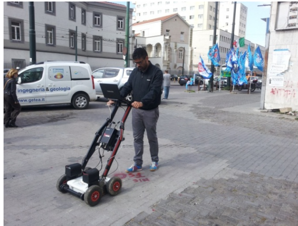
Figura 21 : Scansione presso sondaggio S1
