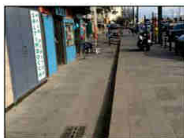
FOTO 3 - Dettaglio del marciapiede di Via Alessandro Volta
