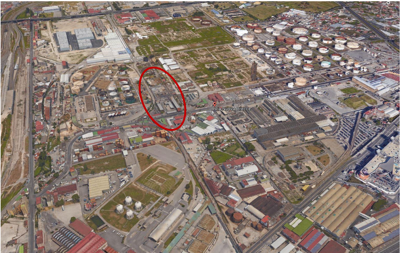
Figura 2 – Inquadramento ortografico con vista 3D dello stabilimento della ASIA di Ponticelli (NA)
