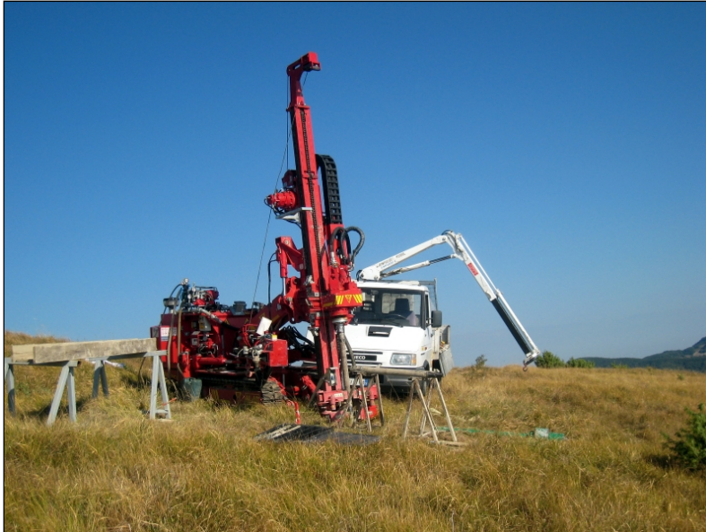
Figura 2 - In foto la realizzazione di un sondaggio verticale con carotiere
