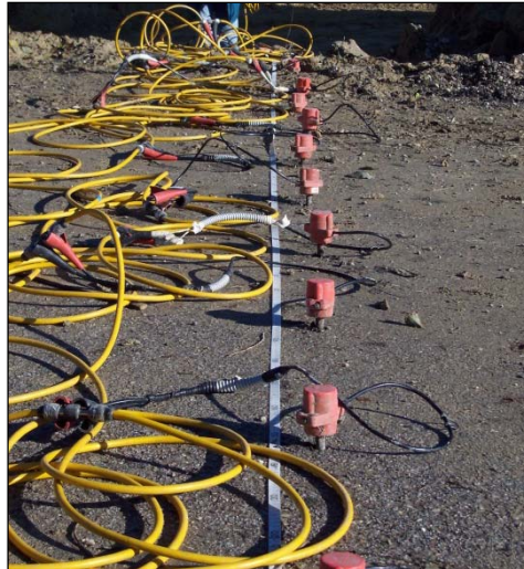
Figura 3 - Indagine sismica - Down Hole
