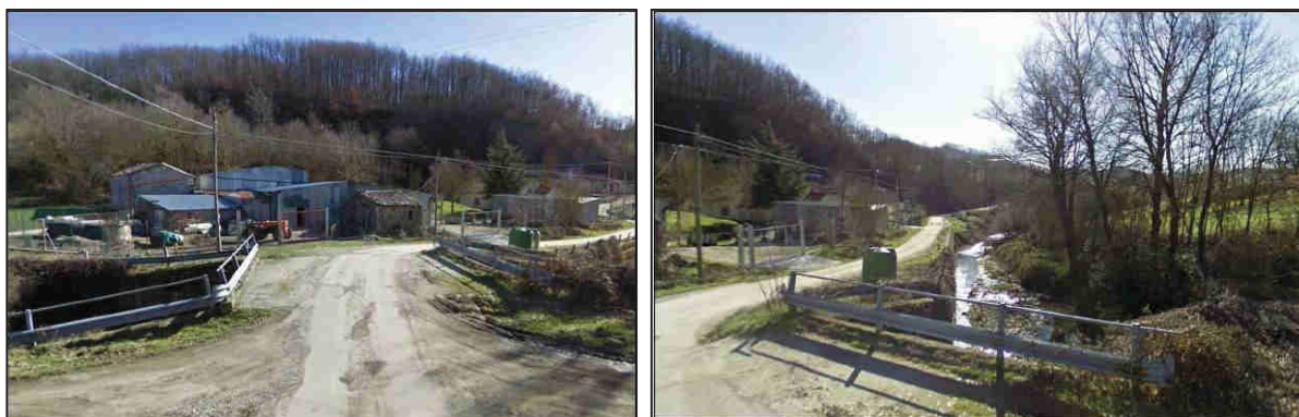
Figura 72 - Stato di fatto attraversamento n.1.
