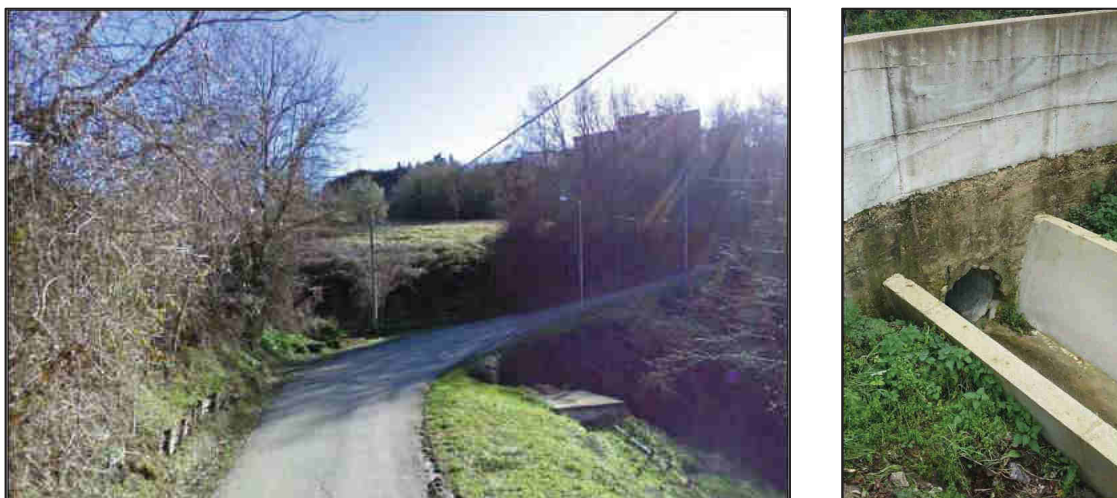
Figura 78 - Stato di fatto attraversamento n.4.
