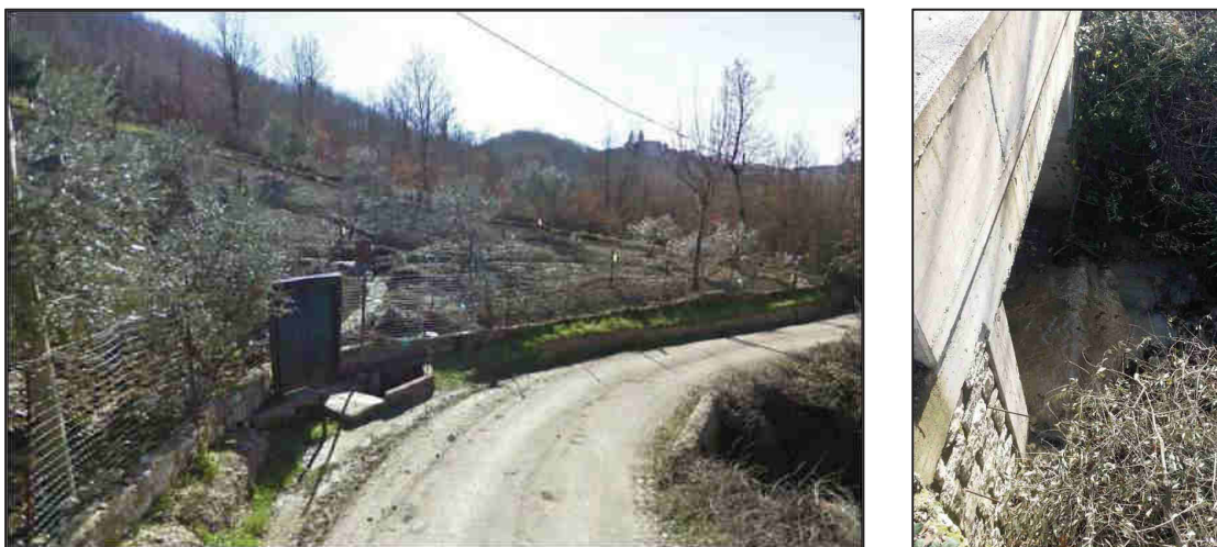
Figura 74 - Stato di fatto attraversamento n.2.
