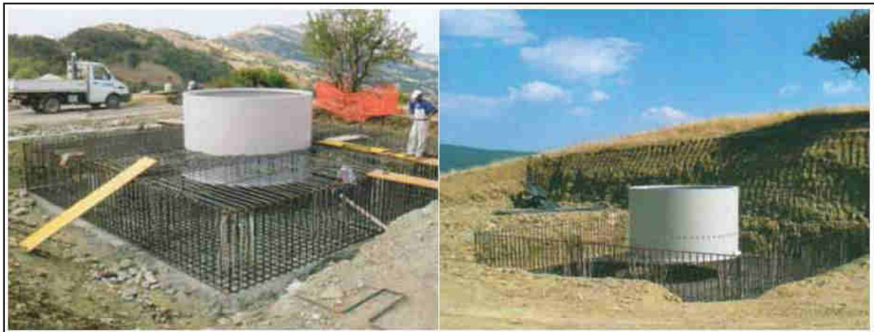
Figura 44 - Fondazione degli aerogeneratori.
