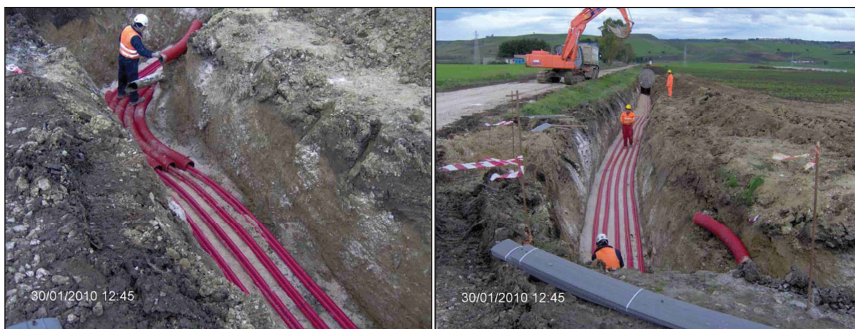
Figura 59 - Rappresentazione della fase di lavorazione inerente la posa in opera dei cavi.
