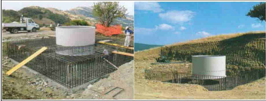
Figura 10 - Fondazione degli aerogeneratori.
