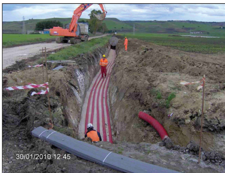
Figura 26 - Rappresentazione della fase di lavorazione inerente la posa in opera dei cavi.
