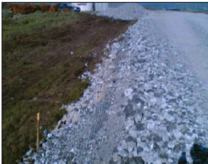
Figura 15 - Superficie stradale in misto stabilizzato e drenaggio.
