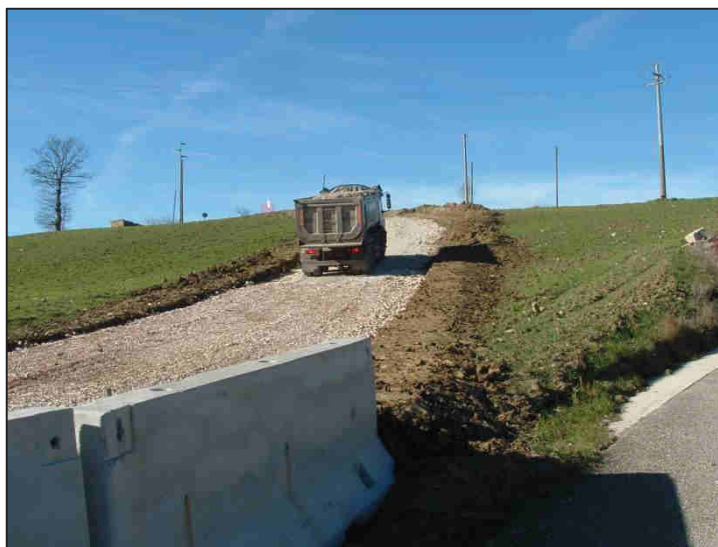
Figura 19 – Raccordo con la S.P. 24 in fase di realizzazione da altro operatore per il parco eolico di Circello.
