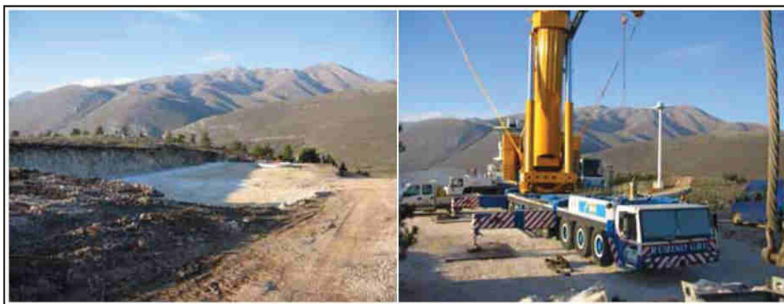
Figura 7 - Foto di piazzole e gru per il montaggio degli aerogeneratori.
