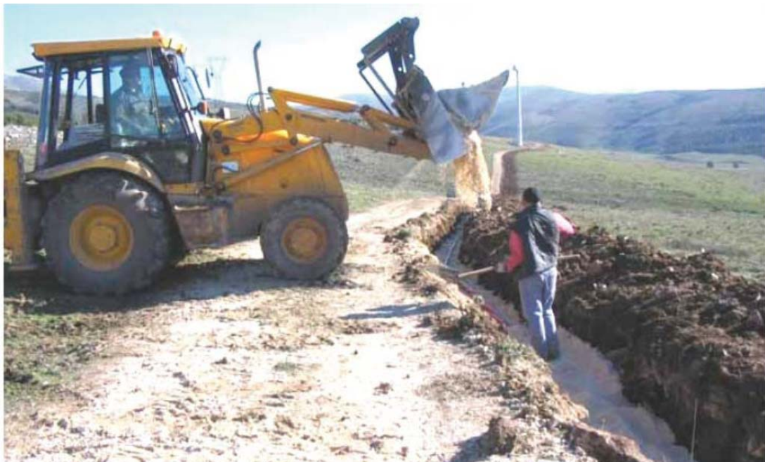
Figura 5 – Lavori di scavo per l'alloggio dei cavi.
