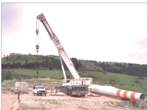
Figura 7 – Operazione di sollevamento dei conchi della torre.
