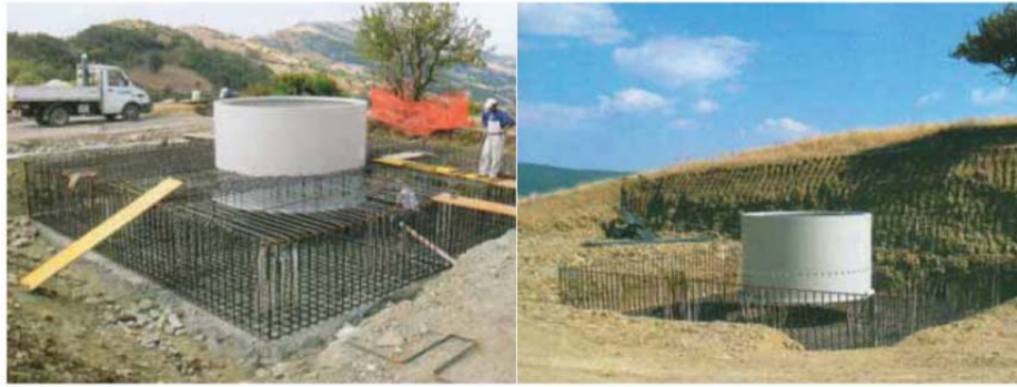
Figura 4 – Fondazioni degli aerogeneratori.
