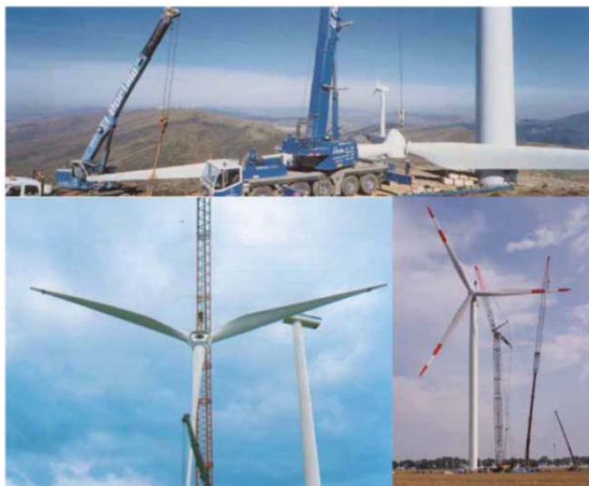
Figura 8 – Sollevamento e montaggio rotore
