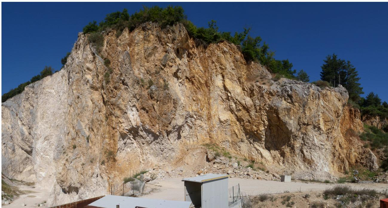
*Foto 1 – Veduta panoramica della parete di cava principale, in primo piano si rilevano dei cunei di roccia e/o delle guglie di erosione da asportare attraverso modeste operazioni di disaggio. In seguito sono riportate le foto di dettaglio di alcuni interventi da realizzare.*
