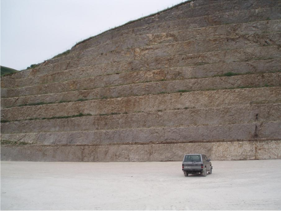
**Foto 8 - piazzale a quota 150 m e sistemazione fino a quota 200 m - microgradonatura**
