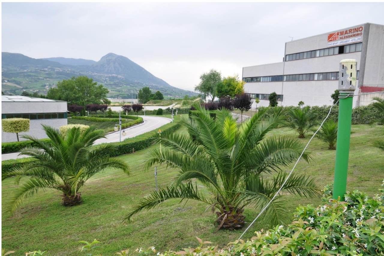
Foto 15.5/D: Il tracciato del metanodotto in dismissione nella Zona Industriale Torrecuso.
