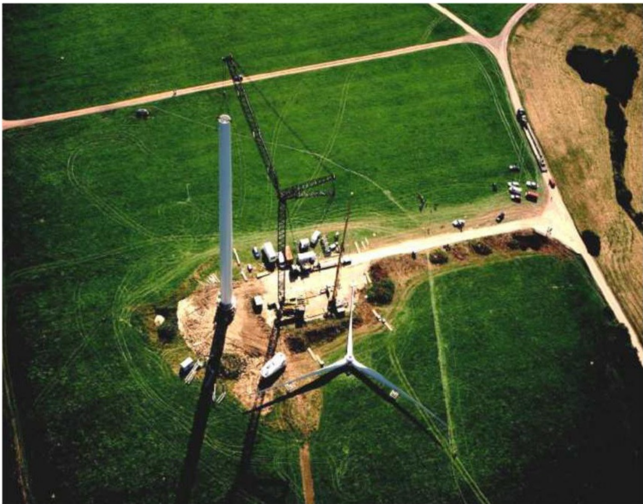
Esempio piazzola di montaggio aerogeneratore
