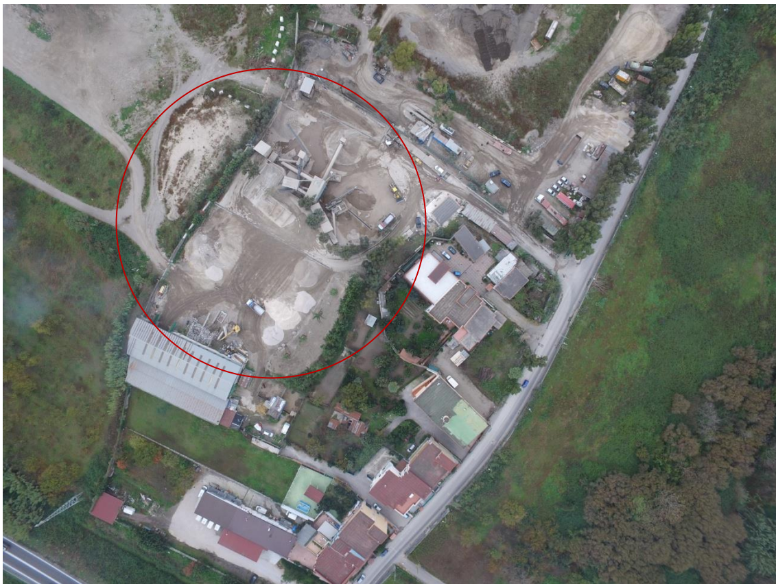
Fig. 2: Foto aerea con evidenziata l'area
