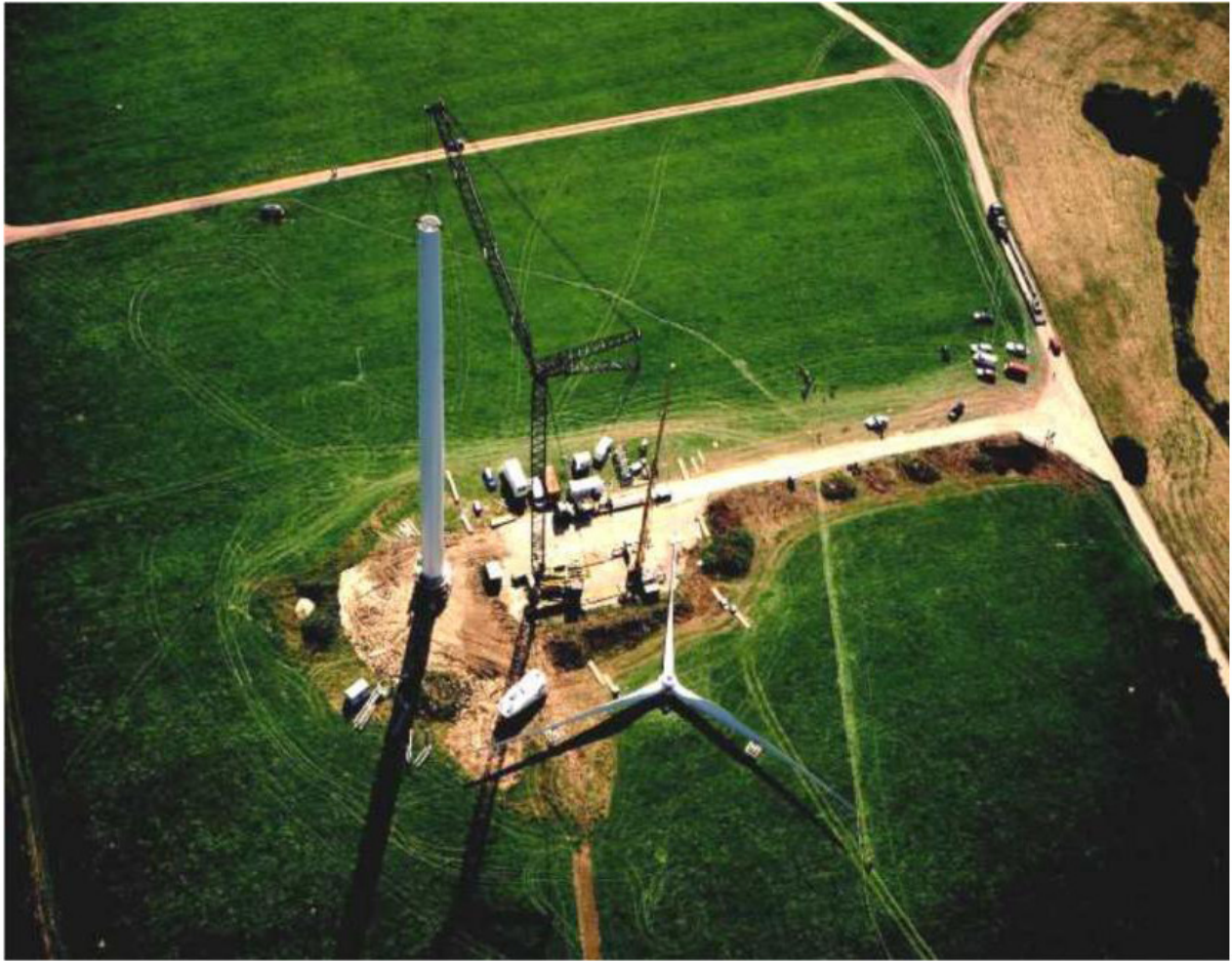
Esempio di piazzola di montaggio di un aerogeneratore
