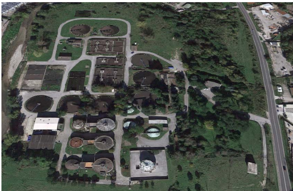
Figura 3.1 - Veduta impianto di depurazione compensoriale del Partenio e dell'Alta Valle del Sabato
