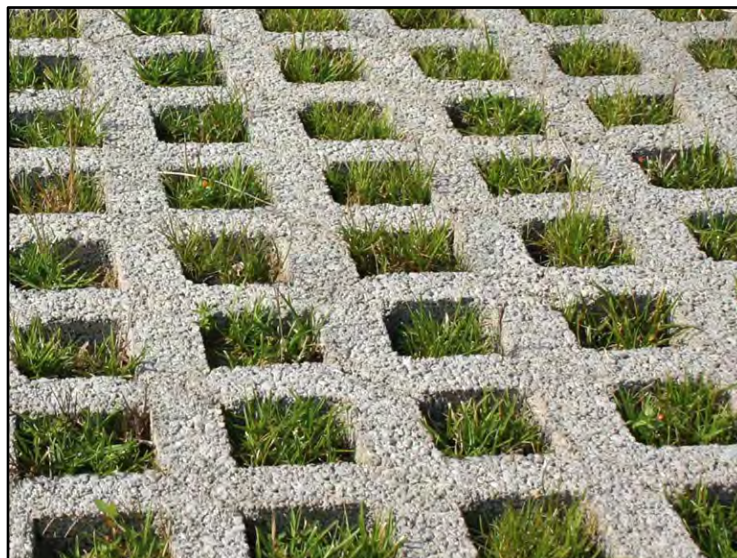
Fig. 21 Tipologia pavimentazione parcheggi a raso
