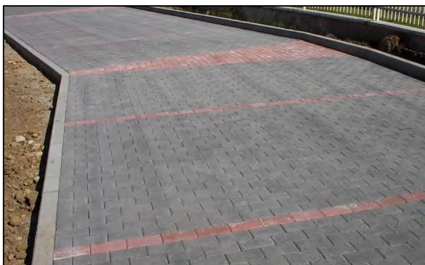
Fig. 23 Tipologia marciapiede in masselli di cemento
