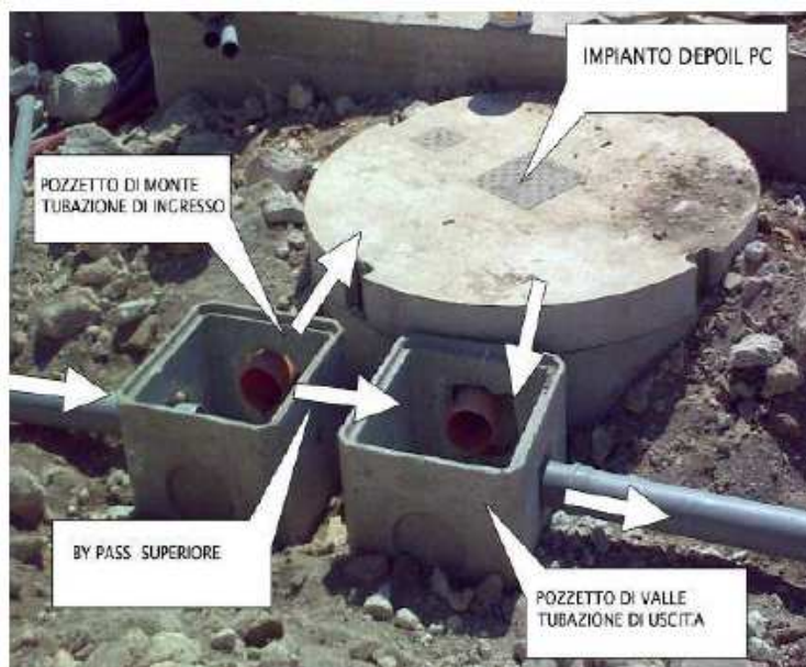
Esempio di installazione
