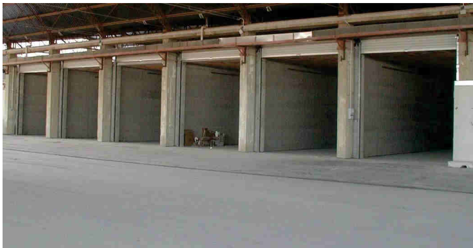
Figura 13 - Vista dei tunnel
