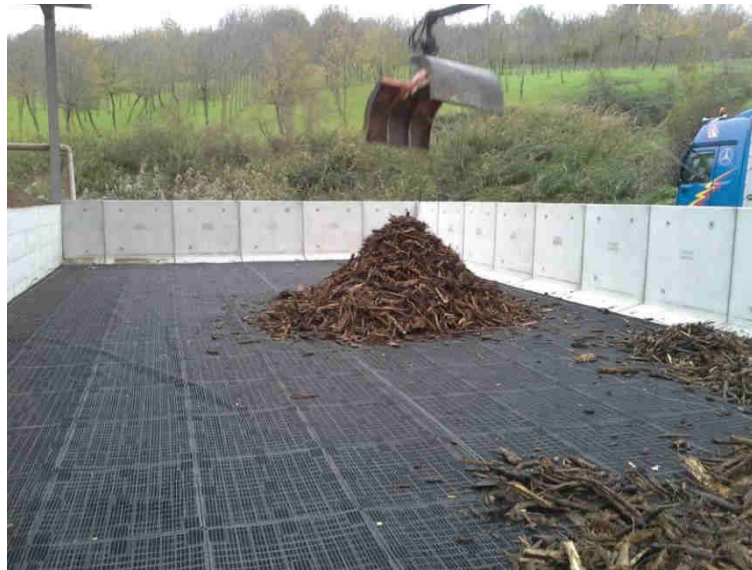
Figura 10 - Esempio di biofiltro in costruzione
