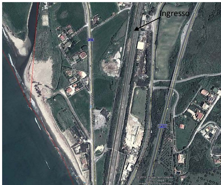
Vista dall'alto dei muri di perimetrazione dell'area oggetto d'intervento
