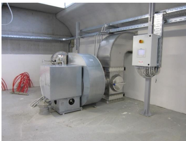
Figura 24: Ventilatore tipo Biotunnel
