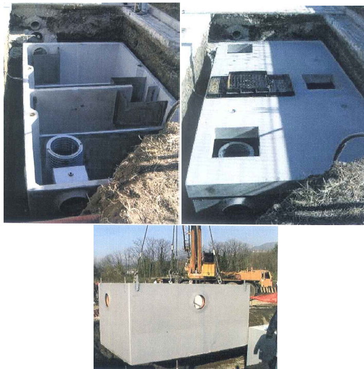
Foto rappresentative dell’impianto di trattamento delle acque meteoriche fornito dalla IDECO Srl
